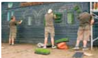
> Mise en place des plantes
