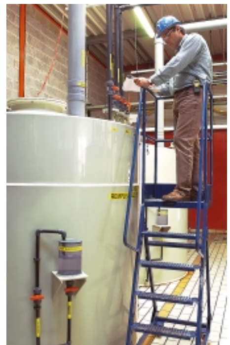
Salle de stockage des produits inflammables
