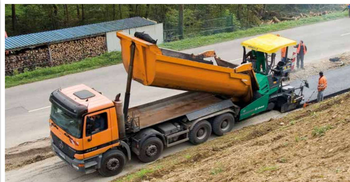
POSE D'ENROBÉ SUR TROTTOIRS/PISTES CYCLABLES COMBINÉS
