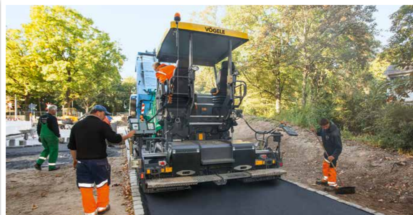
CONSTRUCTION DE CHEMINS EN ESPACES VERTS
