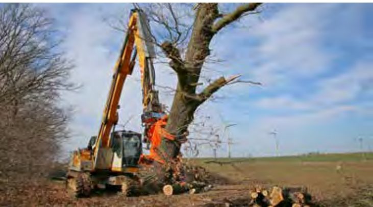
Démontage des arbres en morceaux.
