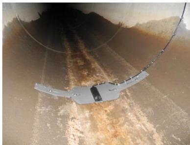
Capteur placé sur un bandeau inox fixé en fond de conduit.
