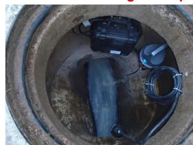
**BELUGA™** associé à un enregistreur autonome installé dans le regard sous tampon.
