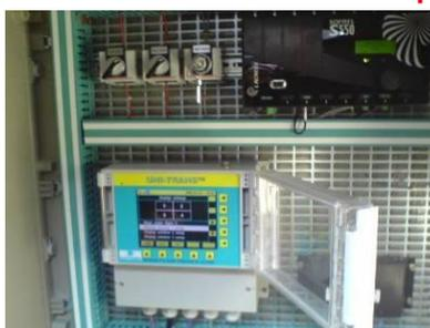
Le capteur **BELUGA™** peut être associé à un IFQ-monitor ou bien raccordé directement à un automate.
