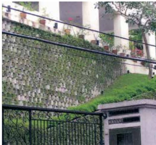
Les ouvrages BETOTITAN® sont des murs monolithes, sans vide intermédiaire, s'adaptant parfaitement aux terrains difficiles et supportant les charges les plus lourdes. Les éléments sont en contact maximum les uns sur les autres.
