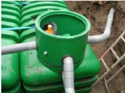
⑤ Raccordement aux gouttières et au réseau d'eaux pluviales
