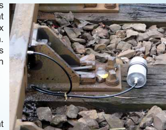
MicroMax® 120 installé sur un contre-rail
