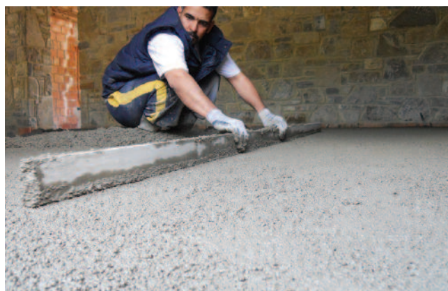
Ravoirage léger et isolant, (plancher chauffant).
