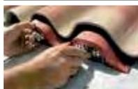
Aucune, se glisse sous la plaque sous-tuile. Le Protège Combles sera bloqué par le tire fond, sans que le poids de la plaque porte sur lui.
