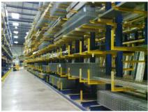
Au-delà de l'utilisation classique pour les entrepôts traditionnels, le rayonnage Cantilever peut être utilisé pour effectuer des installations de stockage autoportantes (avec maçonneries et couvertures) ou automatiques avec transstockeurs.
