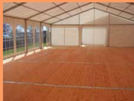
Plancher en bois sur ossature aluminium
