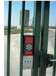
Installation de contrôles d'accès
