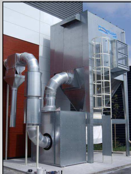
Filtere à trémie à décolmatage par vibreur
