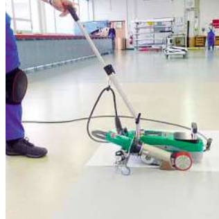
Soudures par recouvrement homogènes et sans pli.
