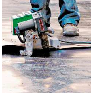
TWINNY T avec panne combinée pour le soudage d'un revêtement d'étanchéité en HD-PE.
