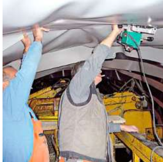
COMET à l'œuvre dans les tunnels ...
