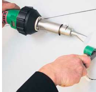
Soudure d'une retouche avec TRIAC PID sur un chantier de construction.
