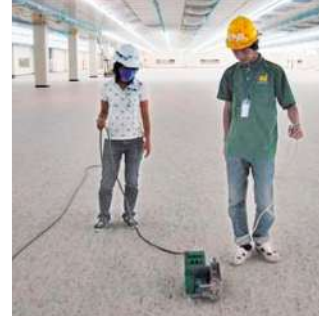
Soudures parfaites avec l'UNIFLOOR E (Vietnam).
