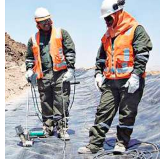
TWINNY S avec panne combinée pour des soudures dans une mine d'Amérique du sud.
