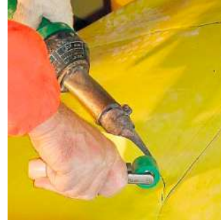
Le rouleau de pression, un accessoire indispensable dans les tunnels.
