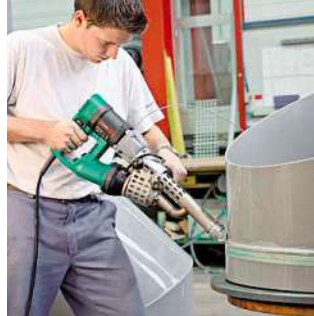
La FUSION 3C à l'œuvre pour la construction de réservoirs.
