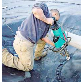
WELDPLAST S6 pour pose sur une décharge.
