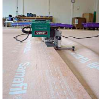
Soudage confortable grâce aux systèmes de guidage.
