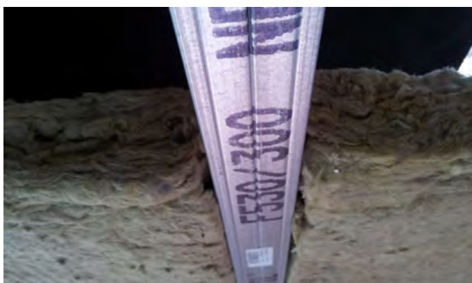
Faire reposer l'isolant rigide de type laine de verre ou laine de roche sur l'ossature.
