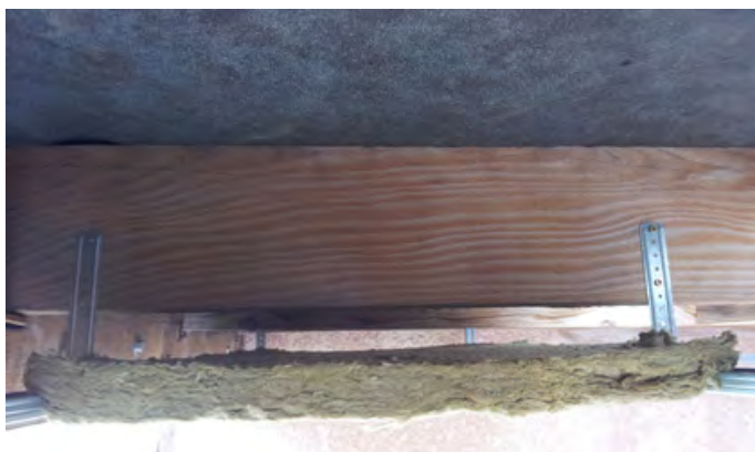
Faire reposer l'isolant rigide de type laine de verre ou laine de roche sur l'ossature.
