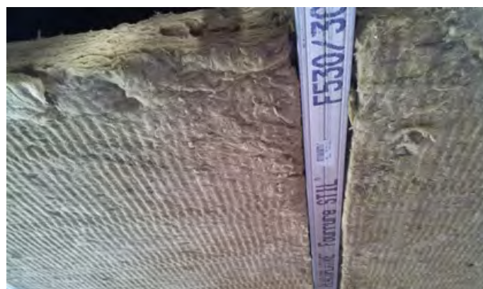
L'isolant feuilluré se trouve au même niveau que la partie basse des fourrures.
