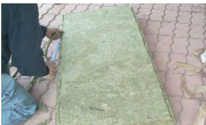
A l'aide d'un cutter ou d'un couteau pour laine minérale, réaliser une feuillure des deux côtés de l'isolant.
