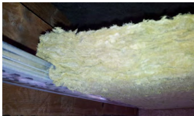
L'isolant feuilluré se trouve au même niveau que la partie basse des fourrures.
