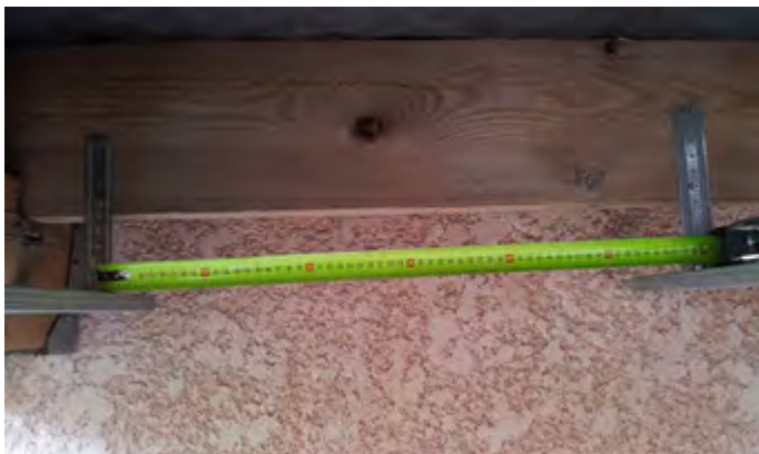
Placer les fourrures, lambourdes ou chevrons avec un entraxe de 40 ou 60 cm.
