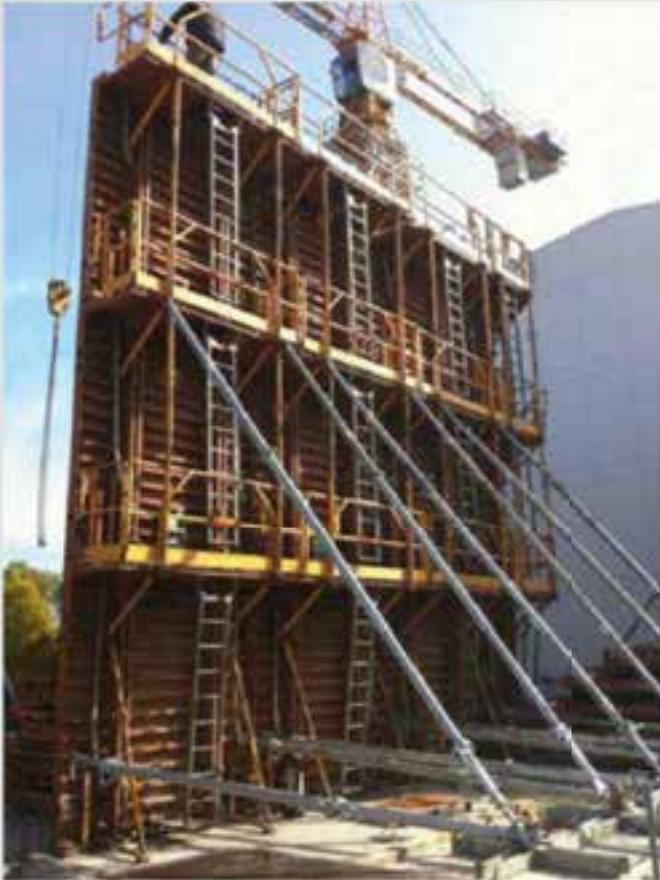
Les coffrages métalliques droits peuvent être utilisés jusqu'à 9,90 m de hauteur de façon simple, en utilisant des étais de stabilité universels A + C + C + B.
