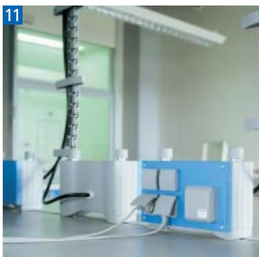
**5** Station de lavage mobile avec alimentation et évacuation par l'aile d'énergie
