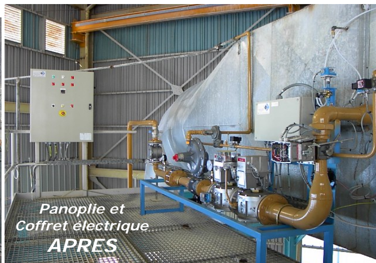
Réhabilitation d'un Four pour traitements thermiques avec équipements TORCH'AIRNOX HT
