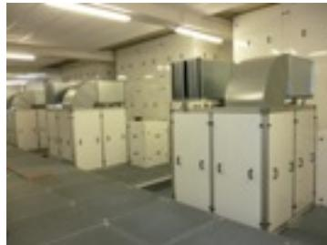
**DALKIA - Chaufferie 45 Mw** : correction acoustique, silencieux fumées chaudière gaz, capotage et silencieux entrée d'air comburant
