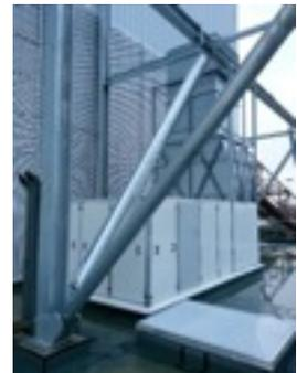
**EIFFAGE THERMIE - Rennes** : ventilation d'un local groupe turbo alternateur - Capotage et cheminée en extérieur
