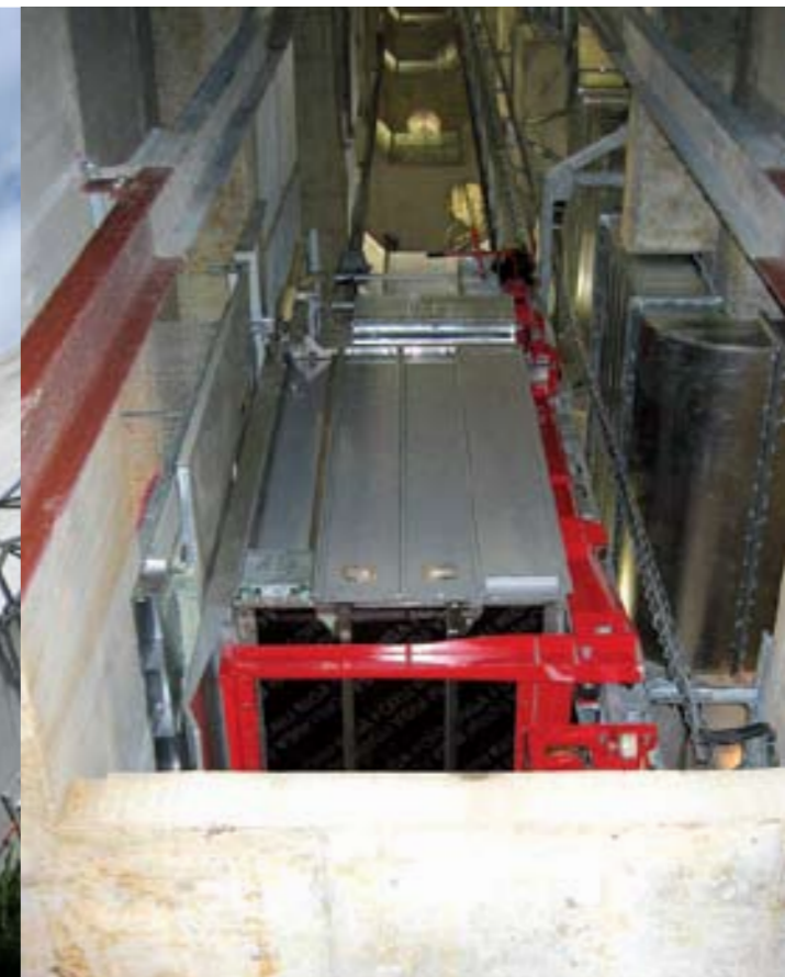
Ascenseurs de maintenance installé dans les pylônes du Pont Gustave Flaubert à Rouen.
