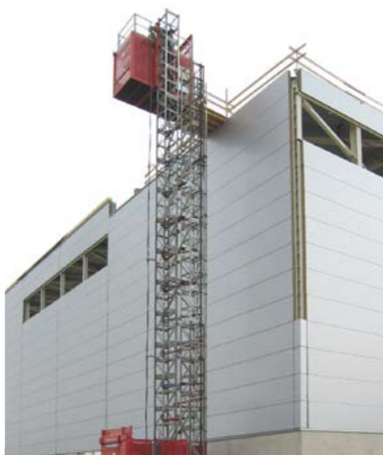
Ascenseur de chantier auto stable (sans ancrages) CMU : 2000 kg.
