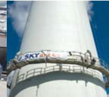
Plateforme suspendue circulaire à 6 treuils.
