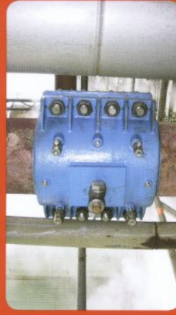
Pose d'une boîte injectée
