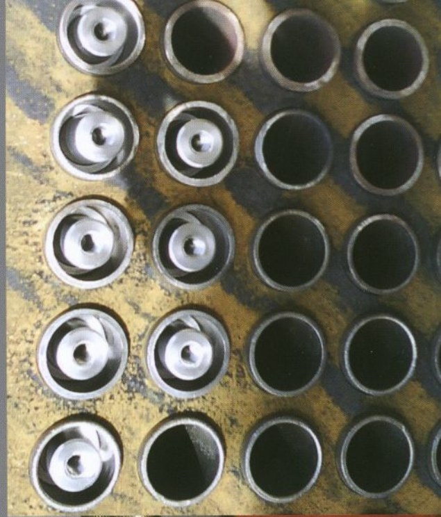
Obturateurs posés sur tubes d'échangeur
