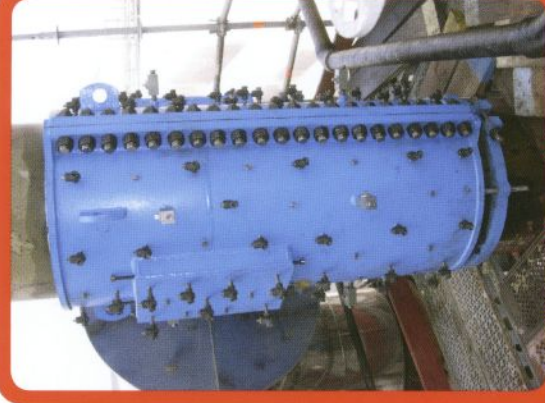
Pose d'une boîte injectée sur collecteur d'essence diamètre 750 mm / longueur 1500 mm
