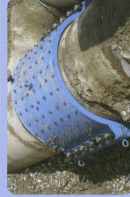
Pose d'une boîte avec "prémoulage"
