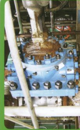
Pose d'une boîte sur corps de vanne
