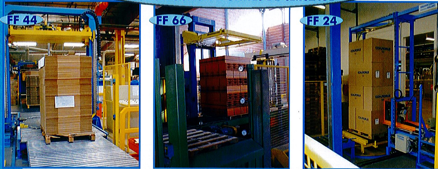
ETUDE / RÉALISATION CONSTRUCTION D'UNITES DE CERCLAGE
