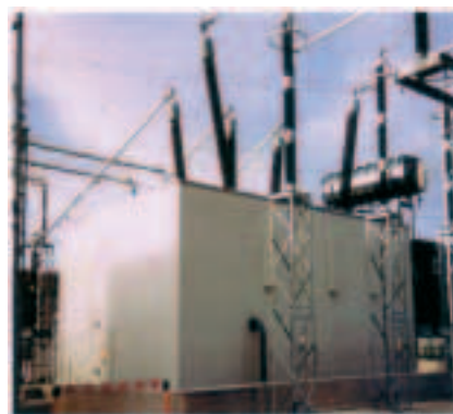
Capotage sur transformateur
