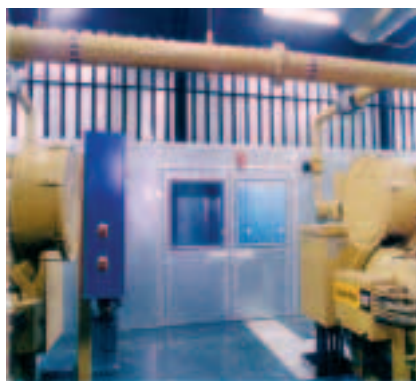
Capotage sur groupe électrogène
