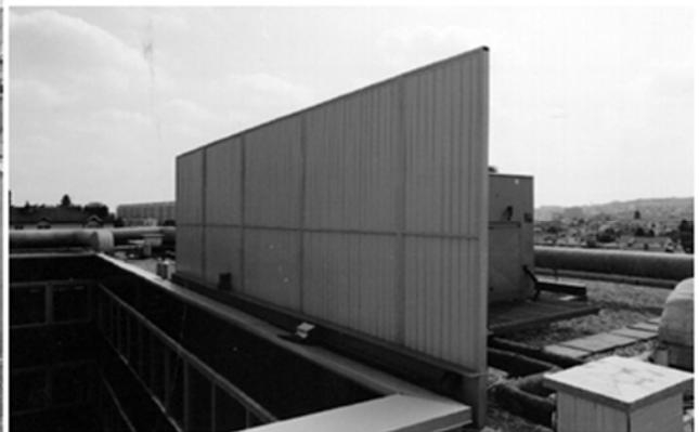
Une ossature en tube carrée est nécessaire pour le maintien des panneaux.
