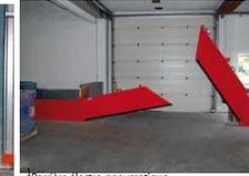
5 Barrière électro-pneumatique (connexion sur alarme...).
