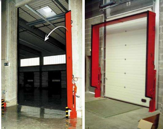
1 Barrière automatique à déclenchement sur sprinklage.
