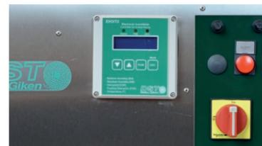
EH3 T2 monté dans un déshumidificateur de type R-61R
