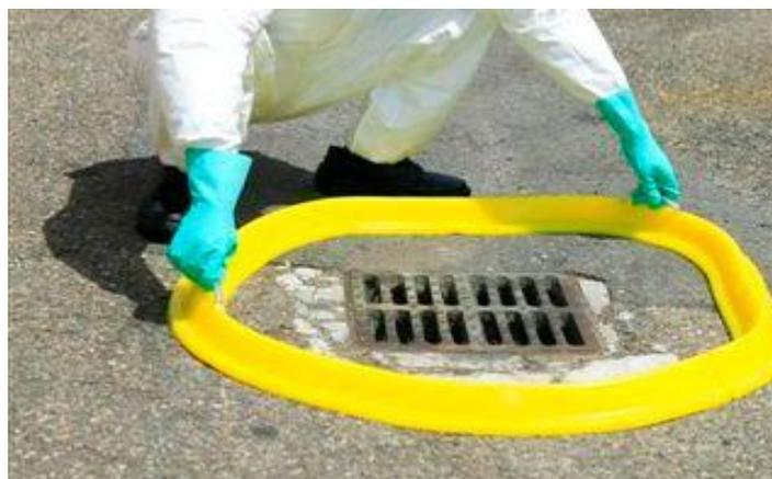
**APPLICATION** : permet de confiner une pollution et détourner les effluents
