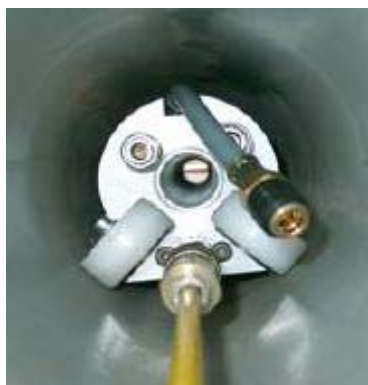
Packer dans une canalisation PVC 200
