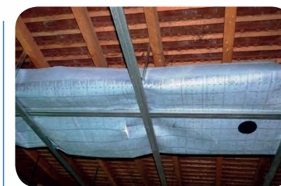
Mise en place d'ISOSAC® entre chevrons et rails à placo
