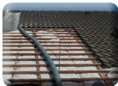
Isolation terminée sous tuiles
