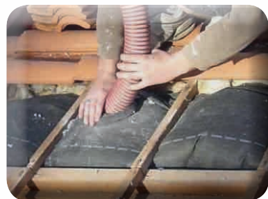
Injection de l'isolant
