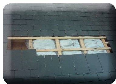
Isolation terminée sous ardoises
