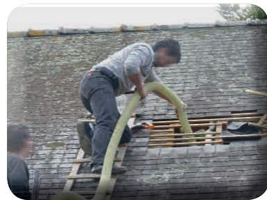
Injection de l'isolant
