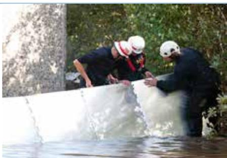
Les barrières anti-inondation Inero sont brevetées et conçues pour protéger jusqu'à 500mm, 800mm, 1000mm, 1500mm ou 1800mm de hauteur d'eau. Les barrières sont faciles à assembler sans apports techniques spécifiques. 4 personnes peuvent installer 100 mètres de barrières en une heure.
