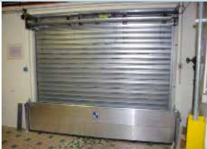
Ce système pérenne allié à une mise en oeuvre simple et rapide vous assure l'étanchéité dès le premier millimètre d'eau.
