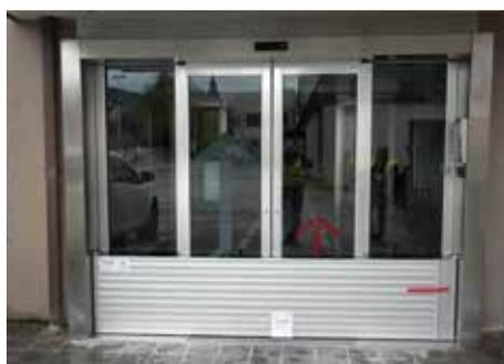
La barrière Acquastop Classic est une protection anti-inondation ergonomique et esthétique constituée d'un profilé aluminium équipé de joints d'étanchéité.
