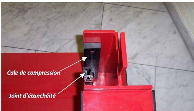
Rail vertical avec joint d'étanchéité et cale de compression avant la mise en place de la traverse.
