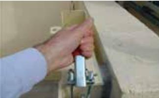
Poignée pour fermer le portail et accrocher les clenches de façon ferme pour finir de compresser les joints verticaux.
