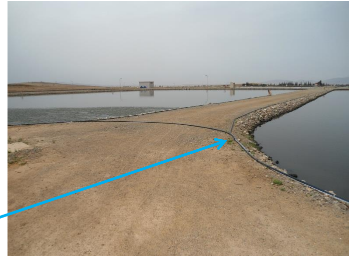
Dispositif AirForce 40/8 relié à un réseau de gaines microperforées
