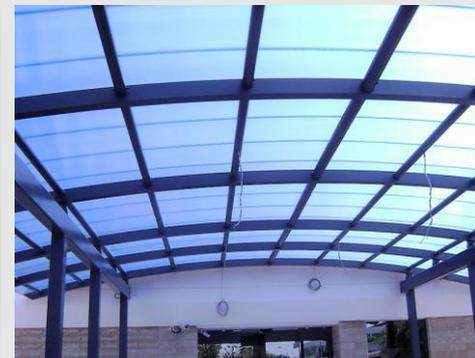
Les plaques de polycarbonate peuvent être **pleines** afin d'obtenir une paroi plus mince, ou plus espacées. C'est ce que l'on appelle le polycarbonate **alvéolaire**, plus utilisé car plus **isolant**. Ce type de verre synthétique se retrouve dans la fabrication de **toiture**, **abris** ou **véranda**.
