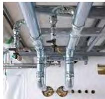
**Raccords à sertir:** - Du DN15 au DN88,9
