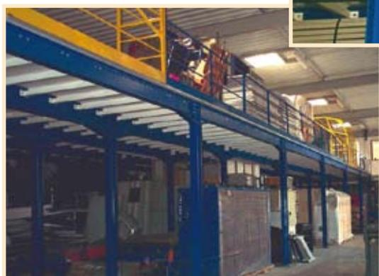
Structure sur poteaux avec renforts de stabilisation
