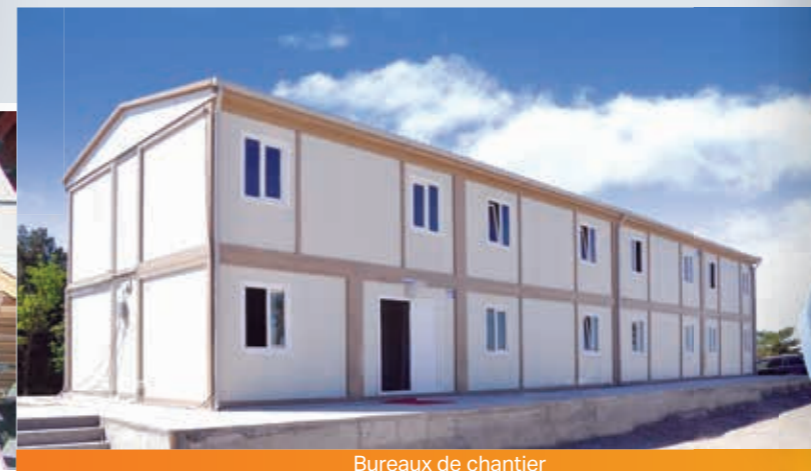
Bureaux de chantier
