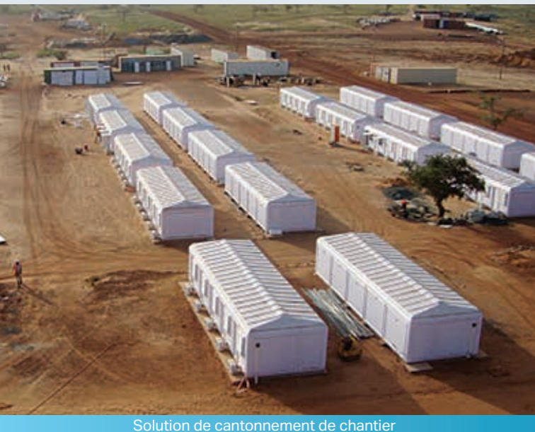
Solution de cantonnement de chantier
