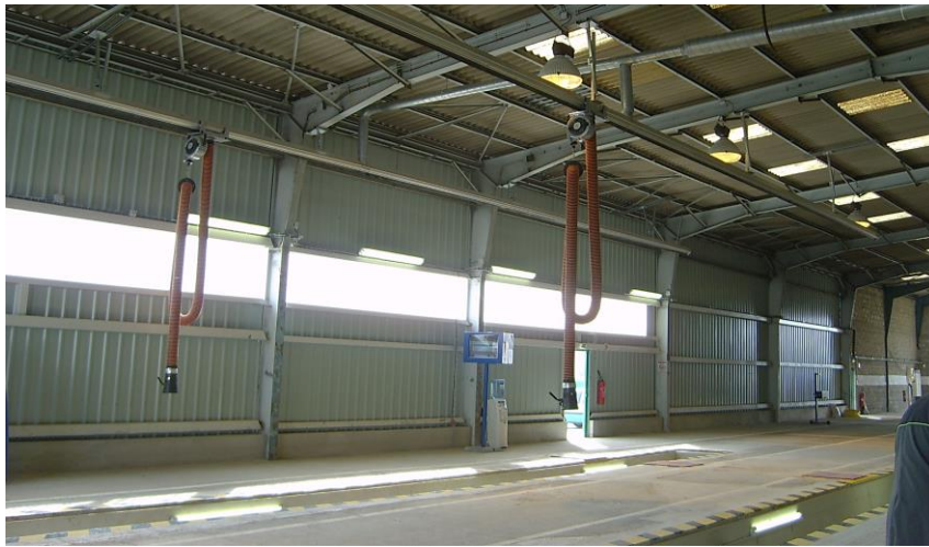
Atelier mécanique VL avec rails et chariots
