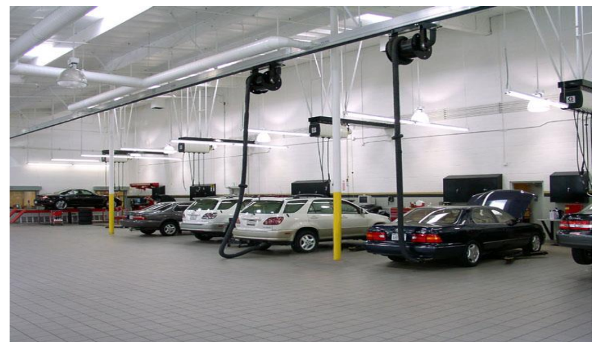
Atelier mécanique VL avec rails et enrouleurs
