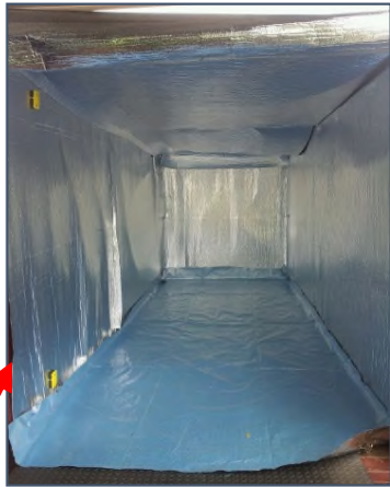
Tapis de plancher avec remontées d'environ 10 cm le long des parois, au fond et devant les portes
