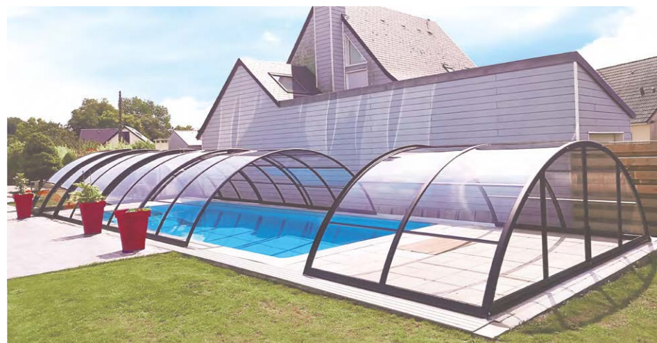
OUVERTURE PARTIELLE DE L'ABRI
