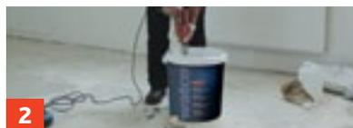
2. Versez la bouteille d'additif dans le seau. Ajoutez lentement la poudre et mélangez avec l'**agitateur pour perceuse** jusqu'à obtention d'une couleur grise homogène.
