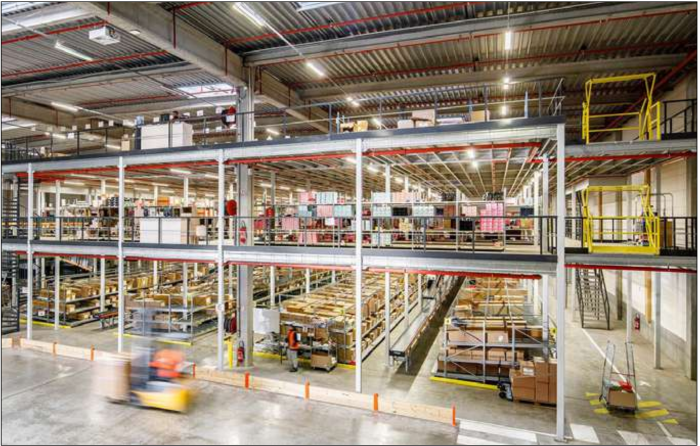
Ensemble de préparation de commandes dans un entrepôt logistique
