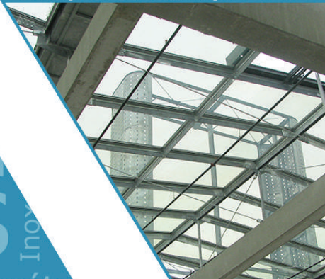
Charpente Métallique - PRS
