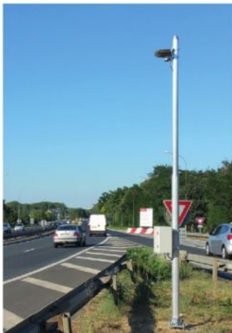
Capteur de détection de gabarit D523 Angers (49).
