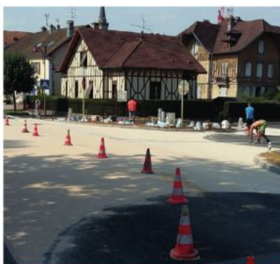
Enduit à froid Granu'MARK® avec agrégats de quartz Rose Haut-Rhin (68).
