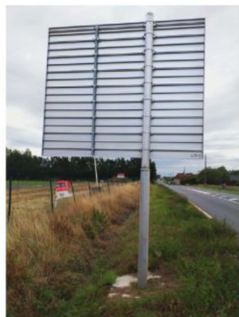
Pose d'un PAL sur 1 mât avec fixation renforcée P0795 (une fixation par lame).
