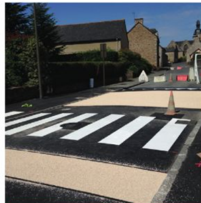
Marquage passage piéton blanc avec enduit EVEREST - Rennes (35).
