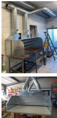
Exemple d'aspiration captage à la source sur bac de décapant
