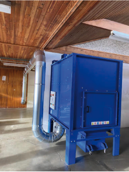
ASPIRATION A LA SOURCE - TABLE DE PONCAGE - ASPIRATION DE POUSSIERE DE PONCAGE
