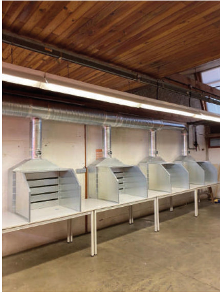
ASPIRATION A LA SOURCE - TABLE DE PONCAGE - ASPIRATION DE POUSSIERE DE PONCAGE
