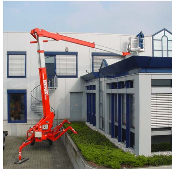
Stabilisation en dévers jusqu'à 16,7 ° / 30,0 %
