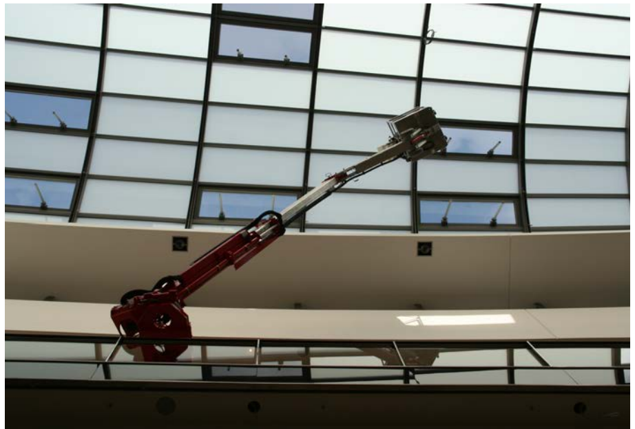
Pour travailler par-dessus les rampes
