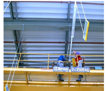
Montage – mise en place
