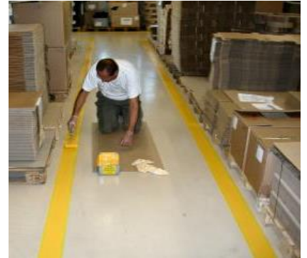
Mise en place de la peinture
