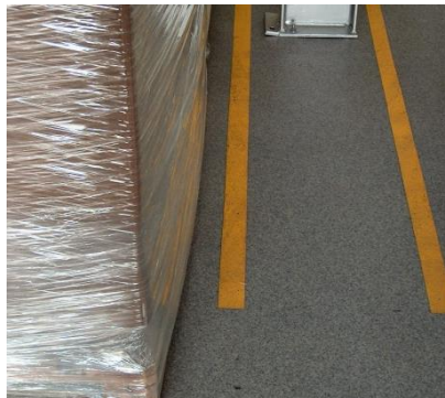
Marquage au sol bandes adhésives
