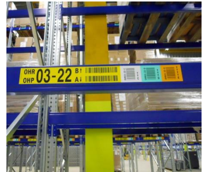
L'étiquette est posée sur la première lisse, le premier niveau étant au sol. La partie jaune indique les emplacements en- et au-dessus de la première lisse. Les niveaux supérieurs sont indiqués par des couleurs différentes.
