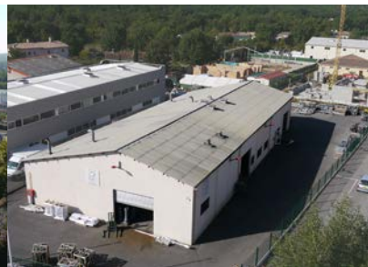
Tournettes Traitement de surface des candélabres en fonte d'acier
