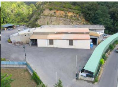
Cagnes-sur-Mer Traitement et stockage Fabrication des vasques
