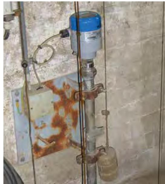
Transmetteur de niveau TDR en tant que protection anti-débordement dans un puits d'eau
