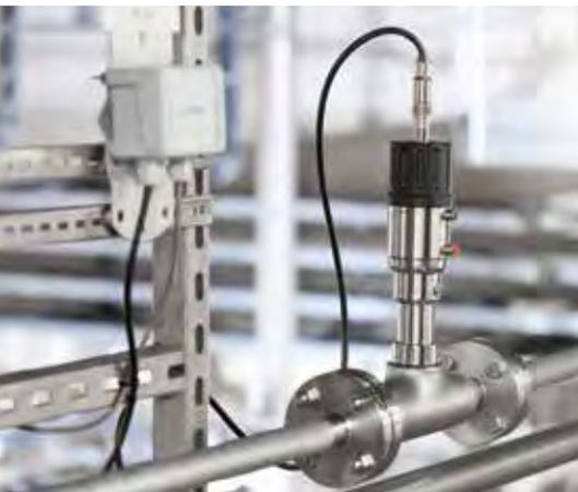
Système rétractable manuel pour sonde de pH dans une usine de produits chimiques
