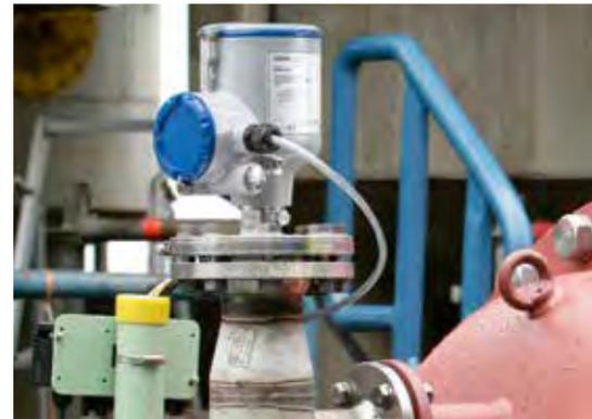
Mesure du niveau de butanol dans la chambre de mesure
