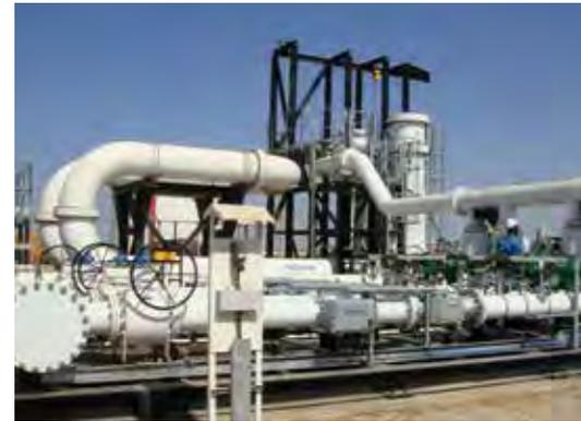
Système de mesure monté sur skid avec système de boucle étalon
