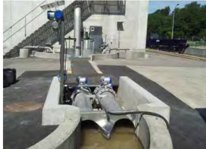
Mesure de débit des eaux usées dans les conduites partiellement remplies
